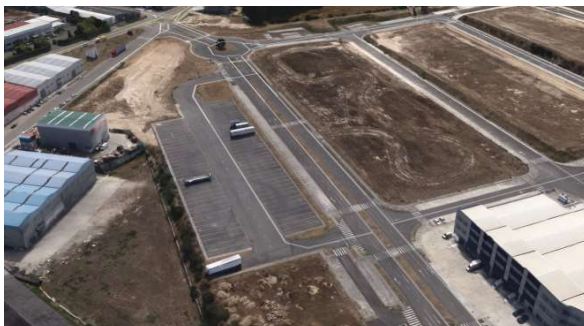
Estado de la obra ejecutada
