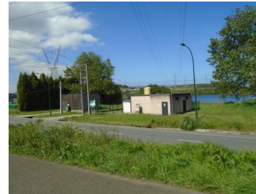
FOTO 49 (Trazado impulsión; inicio en estación de bombeo de Sabón)
