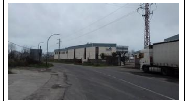
FOTO 4. Servicios afectados en arcén.
