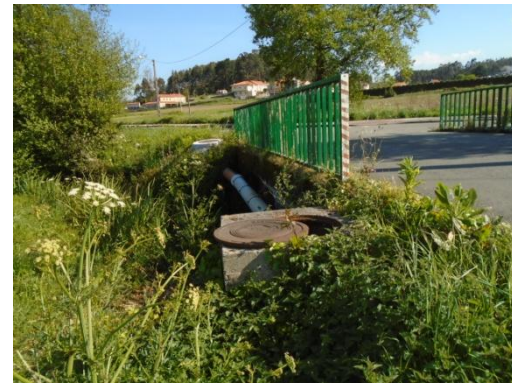
FOTO 16 (Trazado colector; grapado sobre estrutura existente)
