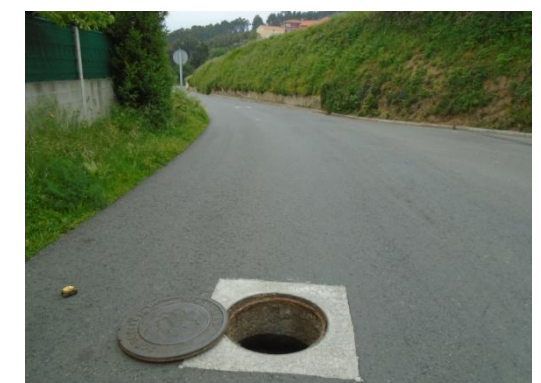
FOTO 66 (Trazado colector; cruce con red de abastecimiento)
