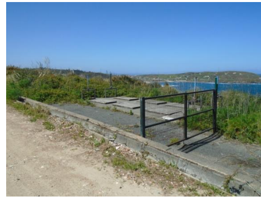
FOTO 82 (Conexión con arqueta de carga del sifón de Bens)
