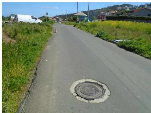
FOTO 59 (Trazado impulsión; pozo descarga impulsión y comienzo del colector de Suevos; cruce con red de abastecimiento)
