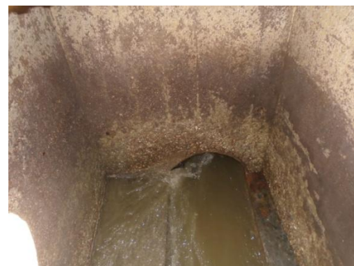
FOTO 60 (Trazado impulsión; pozo descarga impulsión y comienzo del colector de suevos)
