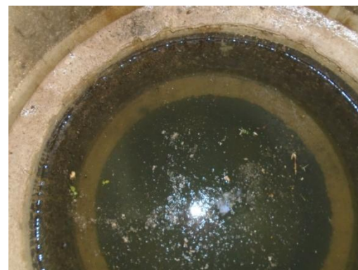
FOTO 06 (Conexión 1 a pozo existente en el Polígono de Morás)
