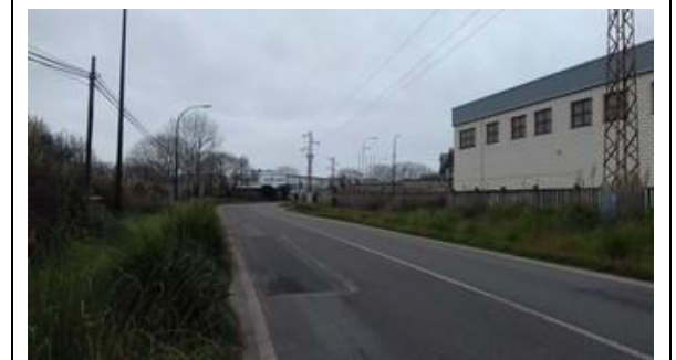
FOTO 6. Se han realizado algunas pequeñas reposiciones de firme en la calzada.
