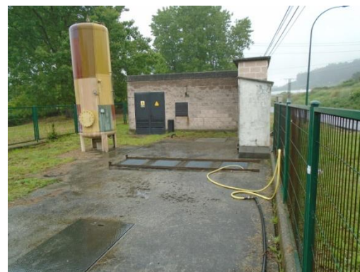
FOTO 47 (Instalaciones e equipos)
