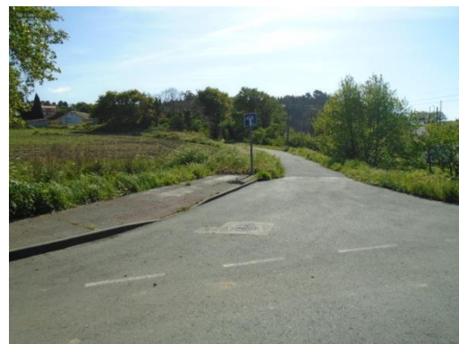
FOTO 17 (Trazado colector; cruce con red de abastecimiento)
