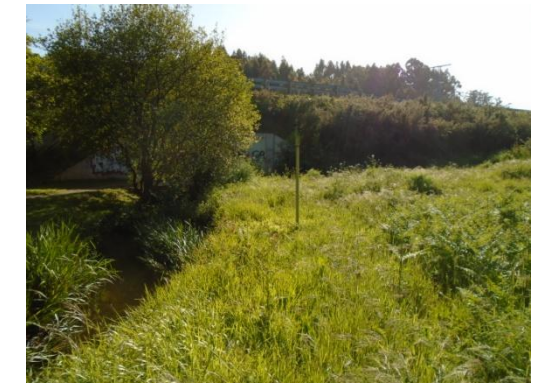
FOTO 20 (Trazado colector; cruce con red de gas)
