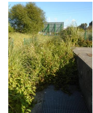
FOTO 34 (Canales de By-pass y de entrada al tanque)
