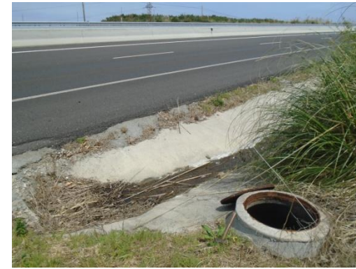
FOTO 73 (Trazado colector; cruce autovía AC-15)
