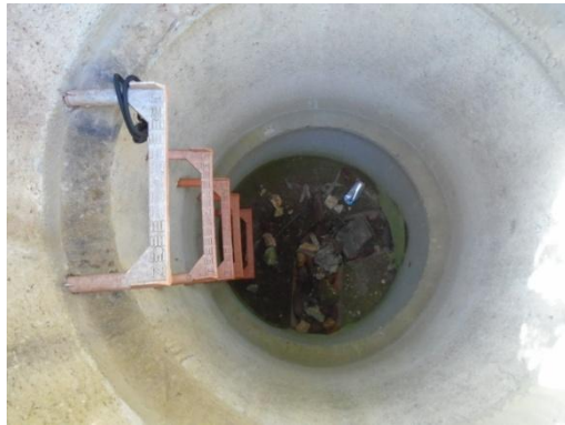
FOTO 01 (Conexión 2 a pozo existente en el Polígono de Morás)
