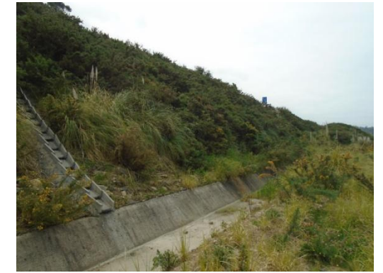
FOTO 74 (Trazado colector; cruce autovía AC-15)
