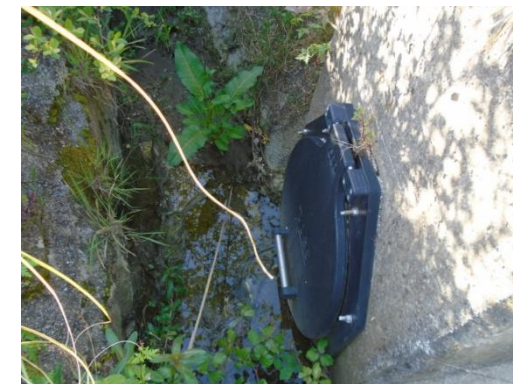
FOTO 33 (Conducción de alivio; clapeta existente)
