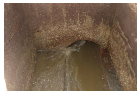
FOTO 60 (Trazado impulsión; pozo descarga impulsión y comienzo del colector de suevos)
