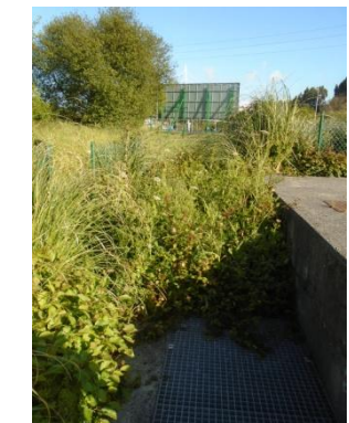
FOTO 34 (Canales de By-pass y de
