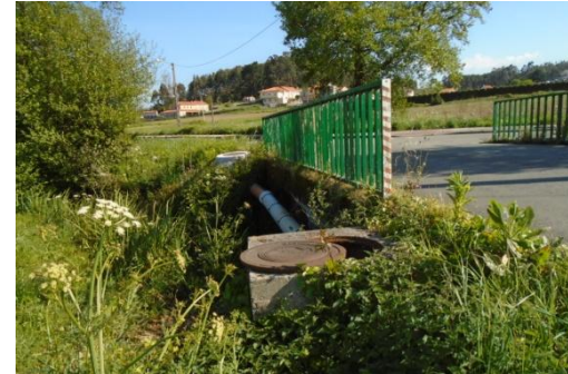
FOTO 16 (Trazado colector; grapado sobre estructura existente)
