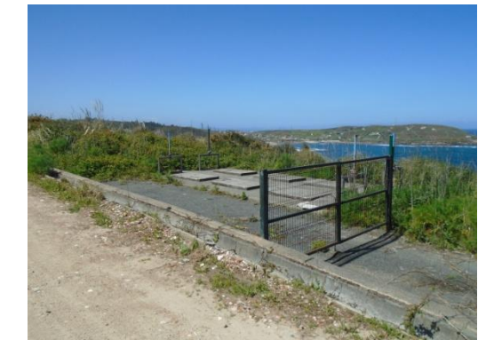
FOTO 82 (Conexión con arqueta de carga del sifón de Bens)
