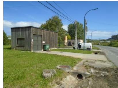
Vista general de la EBAR de Sabón
