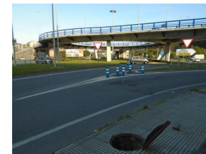
Vista de la Rotonda y del pozo existente previo a la conexión con el I. Sabón
