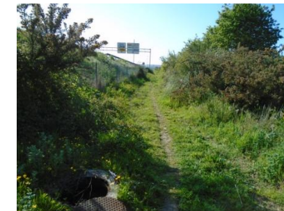
Vista del trazado del interceptor paralelo a la Autovía
