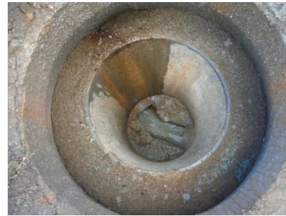
Vista de la red inspeccionada (obsérvese la nitidez del agua)
