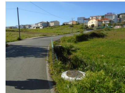
Vista del Grapado del puente sobre el río para la conexión con el Interceptor
