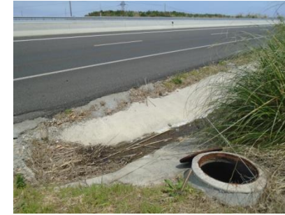
Vista del pozo de cruzamiento de la autovía AC-15
