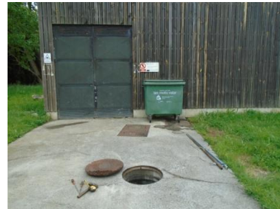
Entrada a la estación de bombeo
