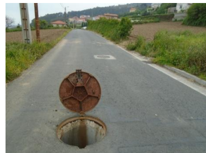
Vista del trazado del Interceptor de Suevos y el colector de pluviales por su derecha
