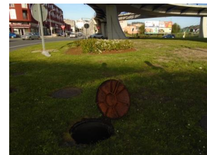
Vista de un pozo del interceptor existente en la glorieta de la carretera
