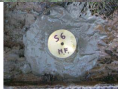
VISTA FINAL DEL EMPLAZAMIENTO Y ARQUETA
