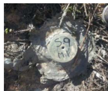
VISTA FINAL DEL EMPLAZAMIENTO Y ARQUETA
