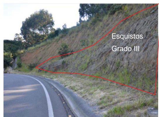
Foto 9.- Afloramiento esquistos moderadamente meteorizados (Grado III)
