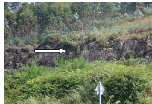
Foto 1.- Talud de la AC-551 excavado en roca
