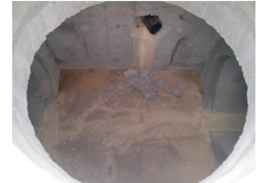
FOTO.- 3 / INTERIOR DE POZO DE PLUVIALES EN VIAL 1.
