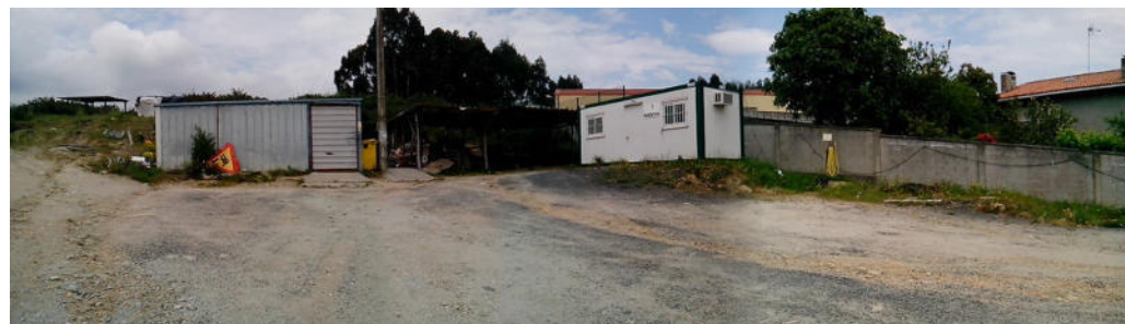
FOTO.- 35 / CASETAS Y ALMACENES DE MATERIALES DE OBRA DE UTE MORÁS
