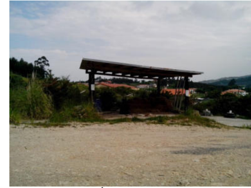
FOTO.- 36/ CONSTRUCCIÓN DE ALMACENAJE ABIERTA EN PUNTO LIMPIO SECUNDARIO
