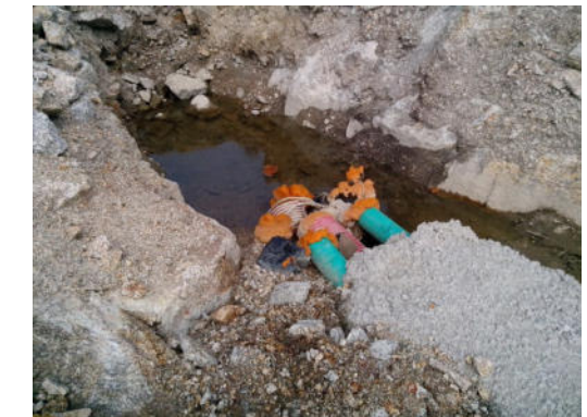
FOTO.- 29 / OBTURACIÓN DE TUBOS SEGÚN REQUERIMIENTO DE FENOSA.
