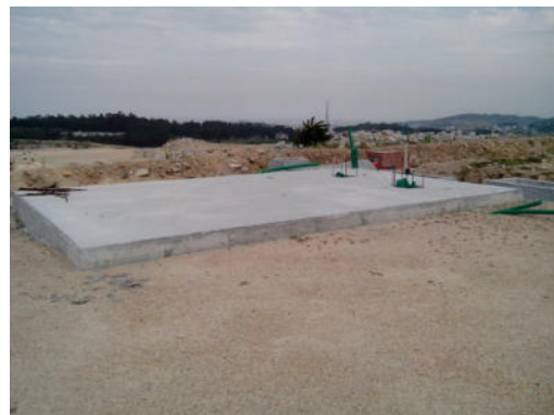
FOTO.- 22 / SOLERA DE CASETA EN LA PARCELA DE LOS DEPÓSITOS.
