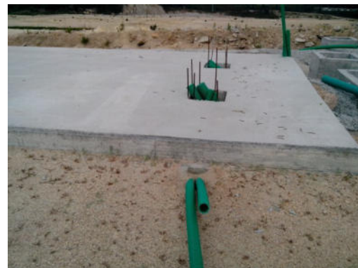
FOTO.- 23 / CANALIZACIONES BAJO LA SOLERA Y HACIA MÁSTIL LATERAL.
