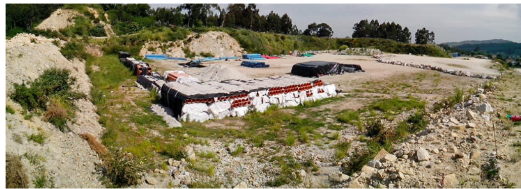
FOTO.- 34 / ZONA DE ACOPIO DE MATERIALES EN PARCELA EQ-01
