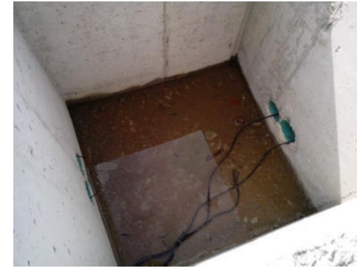
FOTO.- 26 / INTERIOR DE ARQUETA DE PASO
