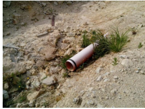
FOTO.- 8 / COLECTOR DE RESIDUALES DEL VIAL 1 CON DESEMBOCADURA AL LAXOBRE.
