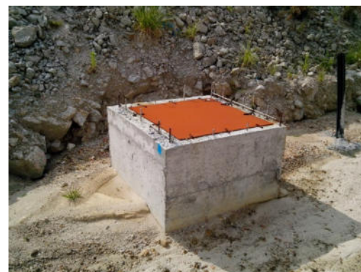
FOTO.- 12 /ARQUETAS DE MANDO CERRADAS CON TAPAS PROVISIONALES SOLDADAS.
