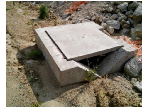
FOTO.- 4 / ARQUETA DE ACOMETIDA DE PLUVIALES EN VIAL 1.
