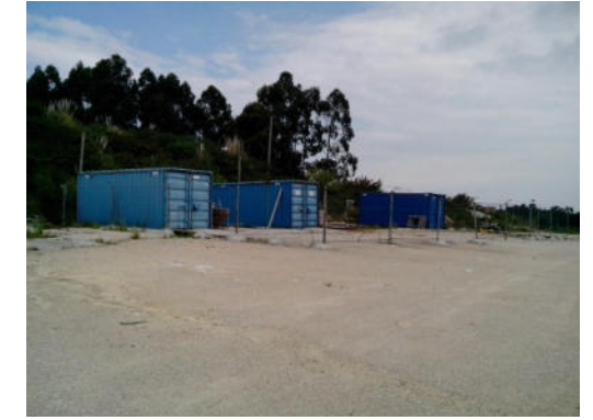
FOTO.- 37 / CASETAS TIPO CONTENEDOR PARA ALMACENAJE DIVERSO
