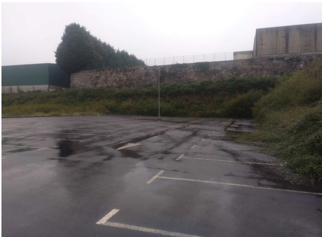
Zona de aparcamento na plataforma superior (27/06/2020)
